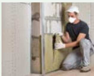
Scheidingswand: 100mm Metalstud- glaswol – gips 11,18 kg CO 2 -eq / m 2 (resp 4,48 • 1,7 • 5 kg CO 2 -eq / m 2 )
