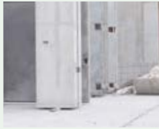
Betonnen wand, standaard beton 513 kg CO 2 -eq / m 3
