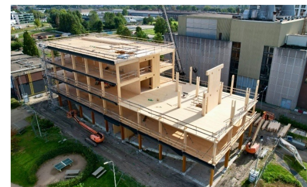
Figuur 3 | HoutWerk 2 in aanbouw
